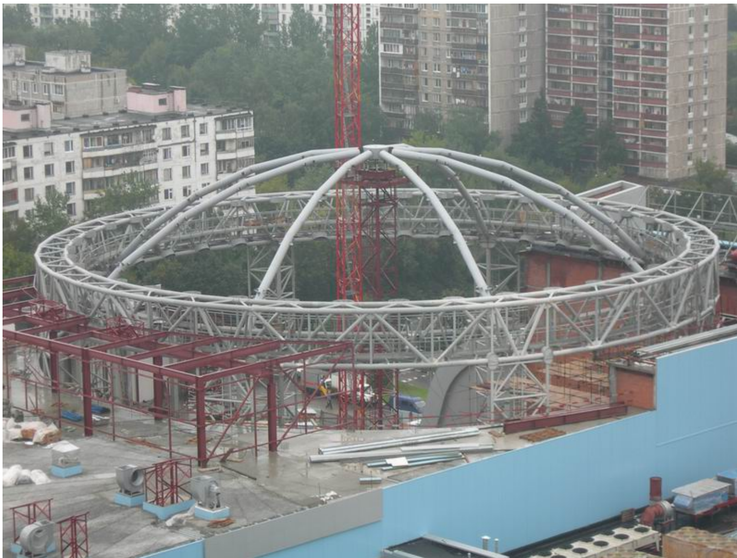
Завершение монтажа атриума , ноябрь 2006 г.
