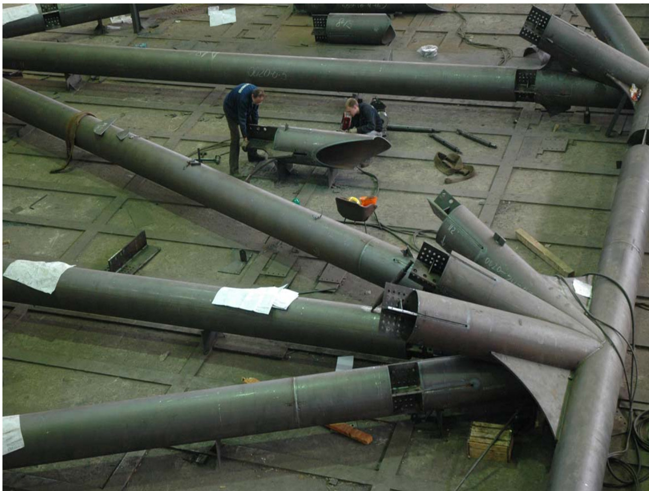
Сборка узлов ферм козырька из трубы диаметром 530 мм.
